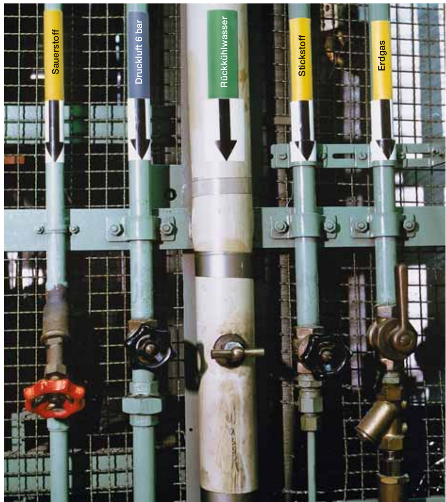
Bild 32 Gekennzeichnete Rohrleitungen.
