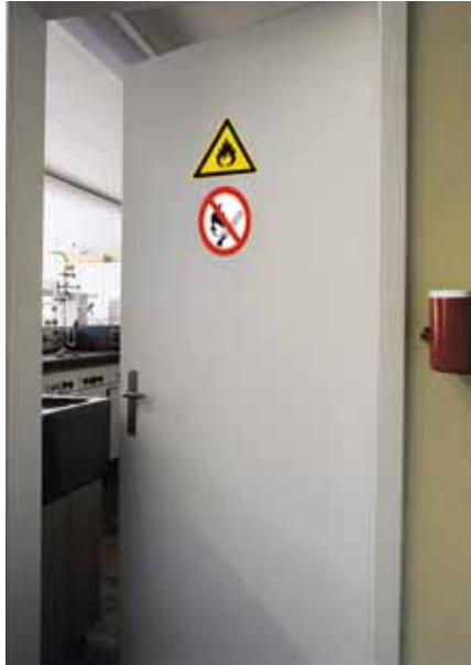
Bild 16 Rauchverbot in einem Bereich, in dem feuergefährliche Stoffe verwendet werden.
