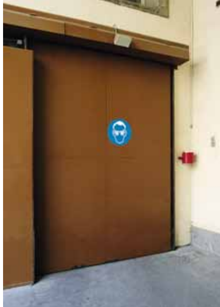
Bild 19 Gebotszeichen an Türe, die zum Gefahrenbereich führt.
